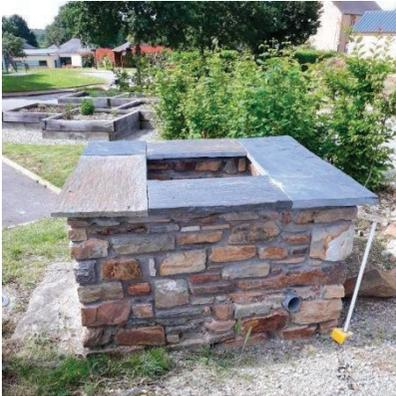
Le puits de la maison Tilheg devait être restauré par le chantier d'insertion de la communauté de communes (construction en pierres). Les compétences n'étant pas disponibles dans le cadre du dernier groupe d'agents de ce chantier d'insertion, nous avons réalisé ces travaux grâce au savoir faire de notre agent communal. Aujourd'hui la partie maçonnerie est terminée. Elle sera coiffée d'une partie métallique à l'image de la photo de droite.
